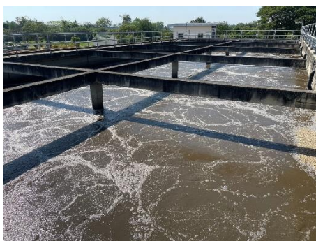
ภาพที่ (15) ระบบบำบัดน้ำเสีย (Equalization Tank)
